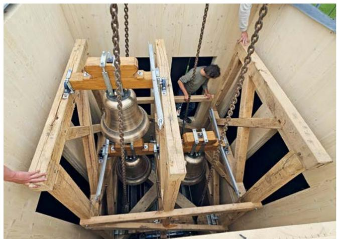
schließlich in die Höhe. Beim Ablassen von oben in den Turm war Zentimeterarbeit gefragt. Es gab kaum Abstand zwischen dem Glockenstuhl und den Wänden. Aber dank guter Präzisionsarbeit aller Beteiligten verlief das Einheben reibungslos.
