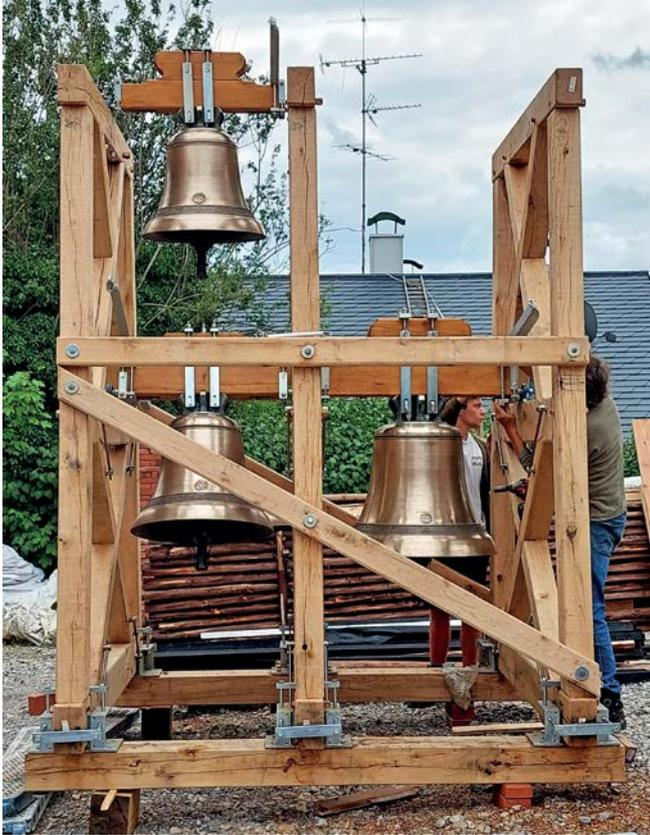
Endlich hängen die Glocken im Turm! Der Glockenstuhl aus massiver Eiche wurde in Einzelteilen angeliefert und fachkundig aufgebaut. Anschließend wurde er mit den Glocken in den Turm eingehoben. Das wollen wir feiern!
